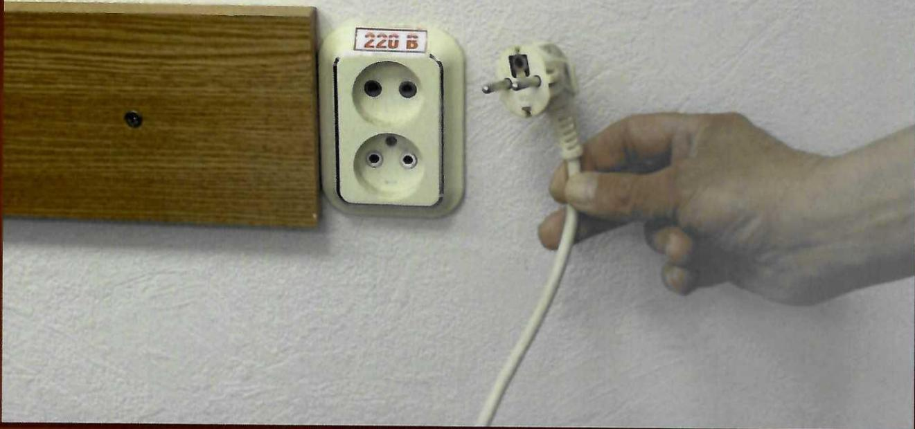
**Можно!** Розетка имеет третий проводник (электроприбор относится к 1 классу защиты от поражения электротоком).
