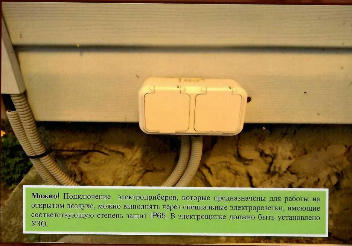
**Можно!** Подключение электроприборов, которые предназначены для работы на открытом воздухе, можно выполнять через специальные электророзетки, имеющие соответствующую степень защиты IP65. В электроштепсельке должно быть установлено УЗО.
